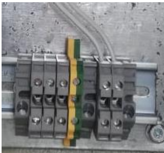
Figura 36 Instalación de Borneras
