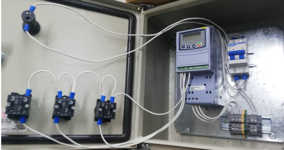
Figura 37 Instalación de los elementos de control del banco
