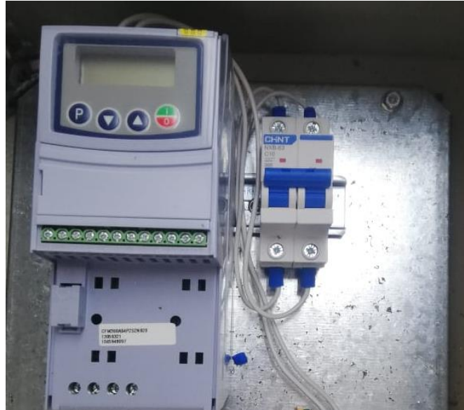
Figura 35 Instalación del Variador CFW300
