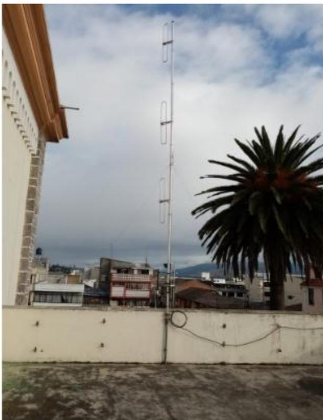
Nota: En la imagen se observa la instalación de la antena dipolo.
