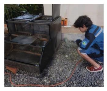
*Nota*. El pintado del banco se realiza con pintura de poliuretano puro mediante un compresor de aire.
