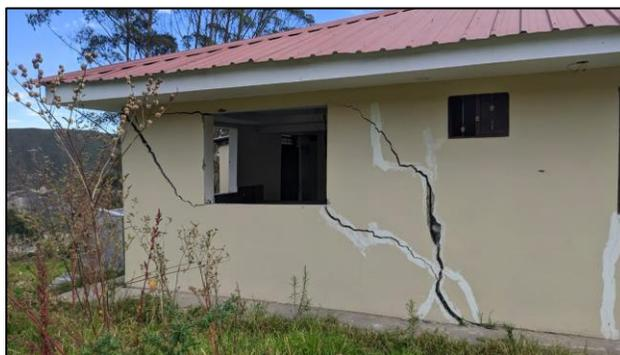
*Nota:* Grietas en la misma dirección de las grietas del suelo, producidas por el desprendimiento que aún se mantiene en el sector.
