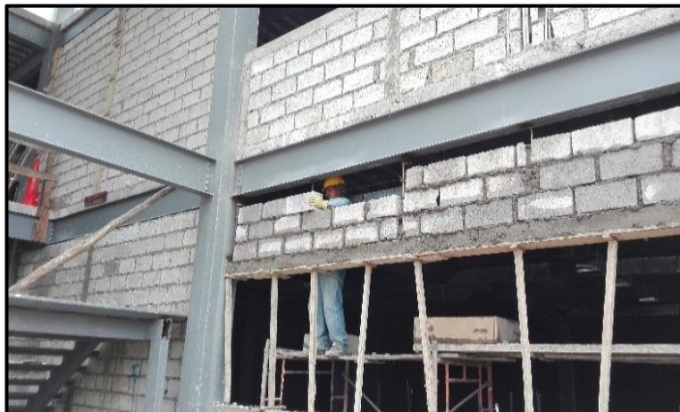
Figura 27: Fijación de bloques.
