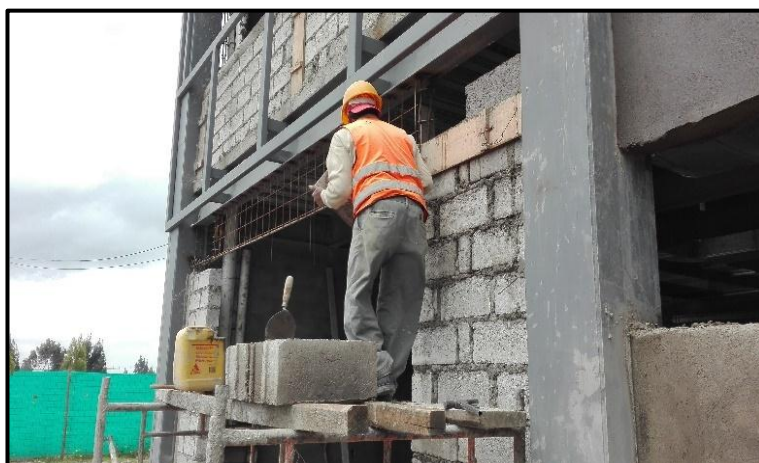
Figura 25: Transporte de material (bloques)
