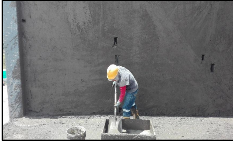
Figura 23: Recoger la mezcla con la pala
