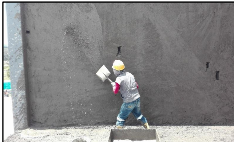
Figura 22: Colocación de material en la pared
