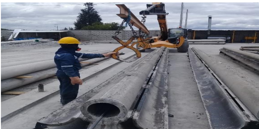
Figura 23 Desencofrado
