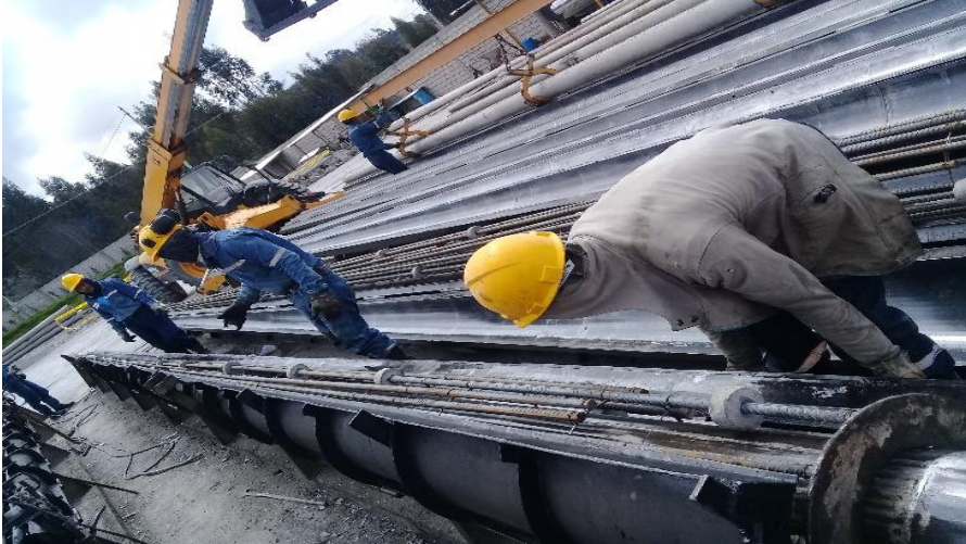
Figura 20 Colocación de la estructura en la formaleta
