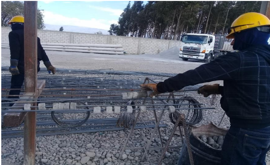
Figura 19 Elaboración de estructura
