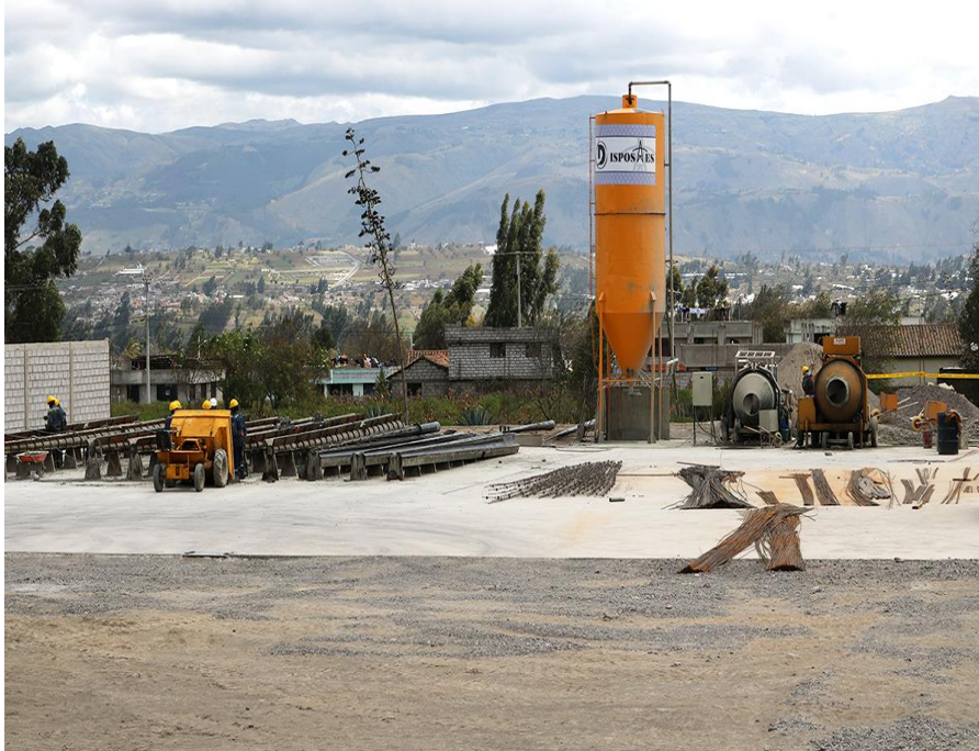
Figura 15 Fachada de la Empresa
