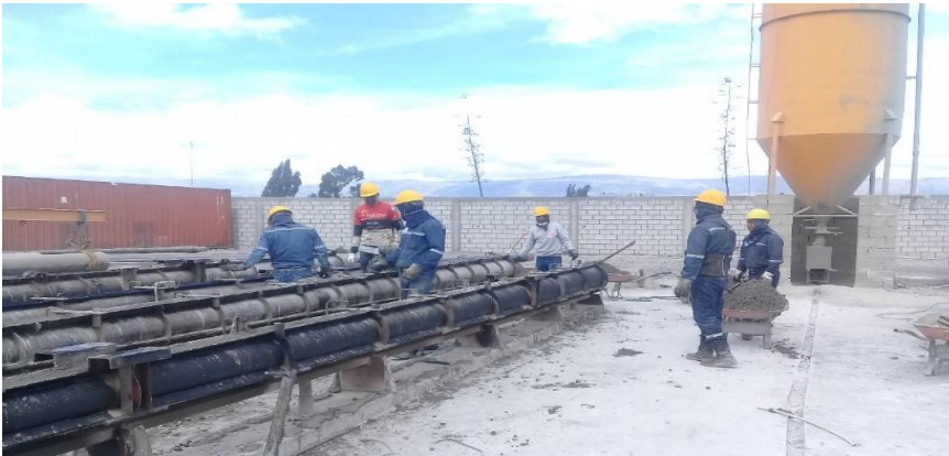
Figura 22 Recepción de mezcla sobre la formaleta
