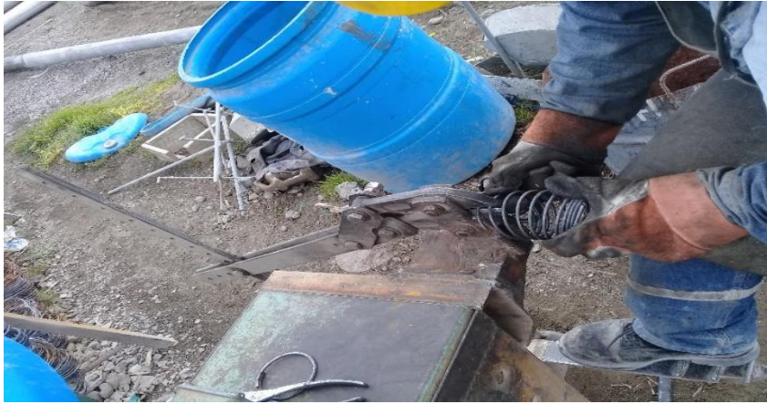
Figura 17 Cortes para estribos
