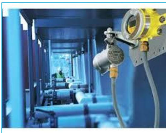
**Figura. 10** Sistema de detección de gases fijo
