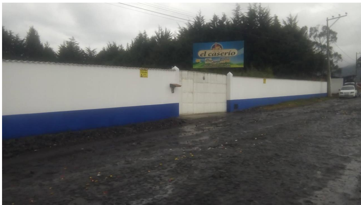
Figura 8. Fachada de la empresa Fuente: (El caserío S.A.)
