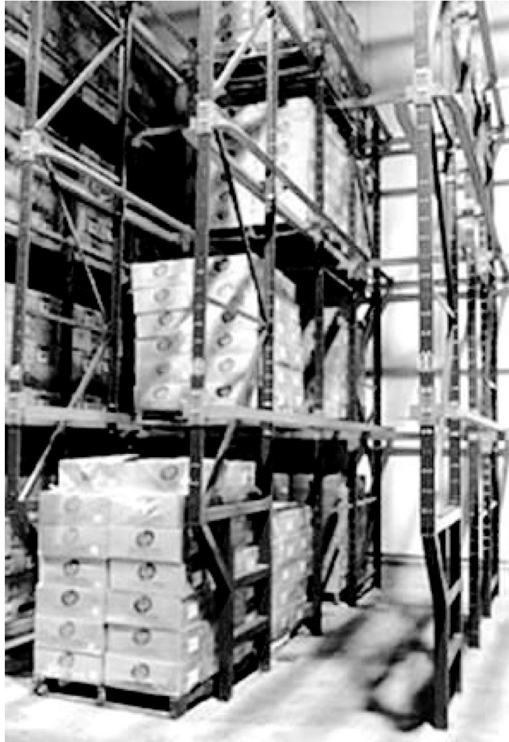
Figura 3.3 Almacenamiento de estanterías
