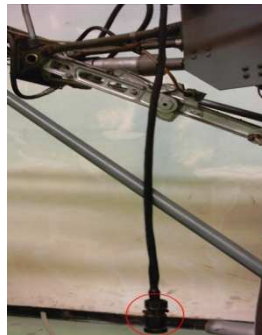
Fig. 3.9: Conectores eléctricos desconectados Fuente: Investigación de campo
