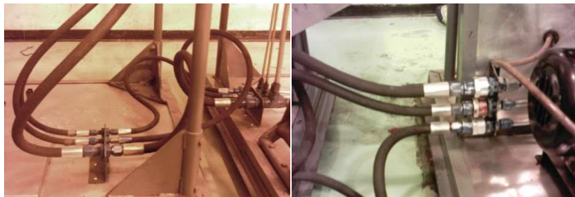
Fig. 3.14: Instalación de cañerías Fuente: Investigación de campo
