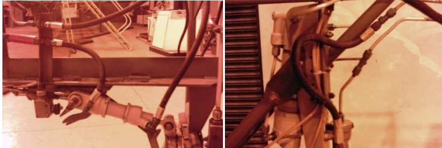
Fig. 3.13: Cañerías de los componentes instaladas Fuente: Investigación de campo
