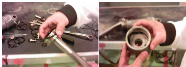
Figura. 3.10: Reemplazo de empaques del cilindro Fuente: Investigación de campo
