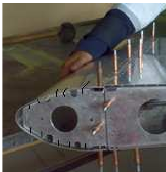
Figura 4.146. Trazado de las líneas donde ubicaran los puntos para taladrar.
