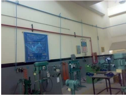
Tubería neumática
