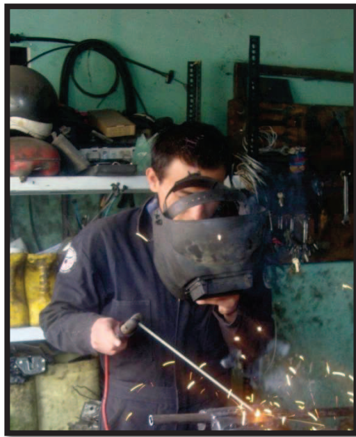
Figura 3.4 Soldado de la estructura de la escalera.
