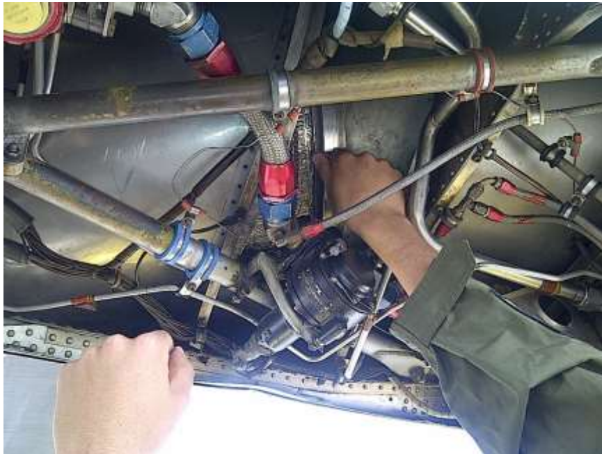
Figura 3. 23 Instalación de pernos en las abrazaderas
