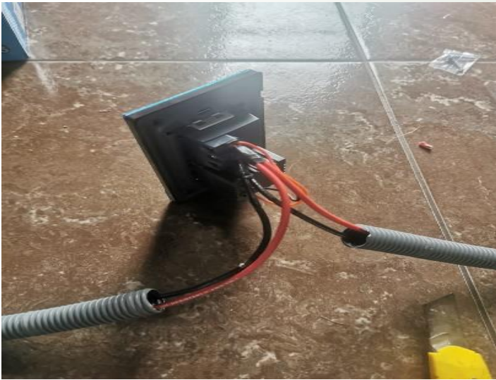
Conexión del cableado
