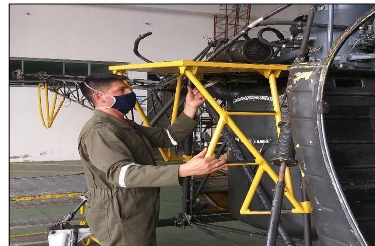
Como último punto se realizó el desmontaje de la plataforma de trabajo para dejar a la aeronave en condiciones operables.
