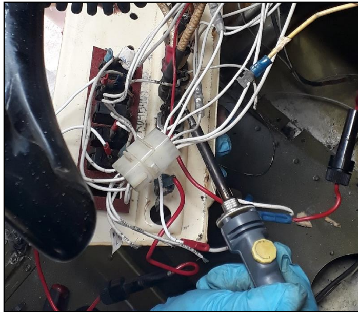
Figura 35 Soldadura en barra bus
