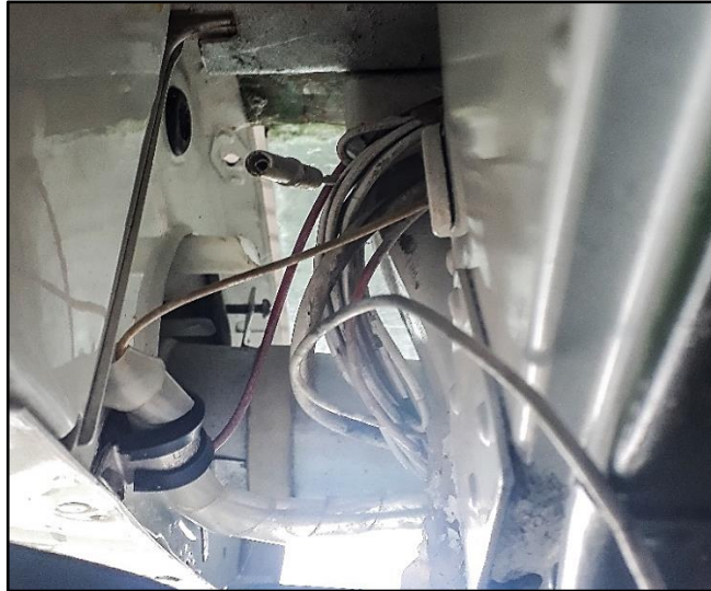
Figura 37 Cableado suelto en ala izquierda
