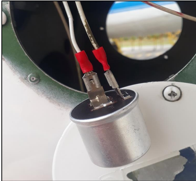
Figura 45 Instalación de flasher
