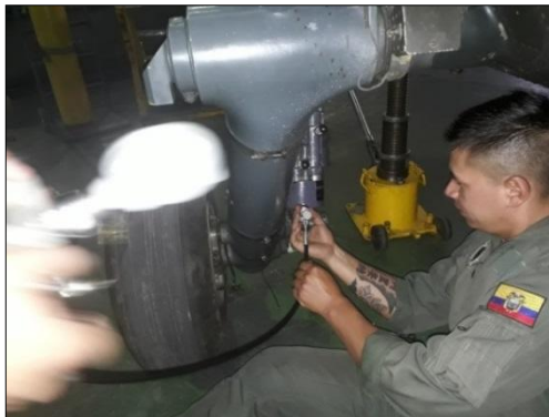
Figura 57 Instalación del Equipo de Control de Presión
