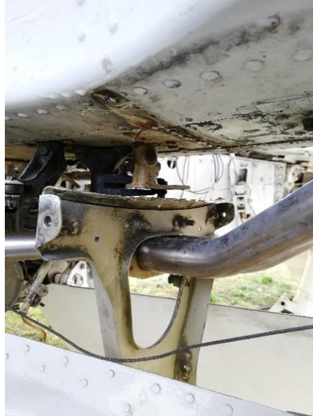
Figura 35 Condiciones de la costilla y fuselaje de la aeronave
