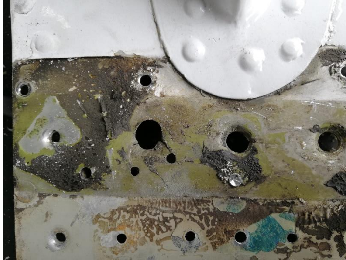
Figura 48 Rajaduras en los puntos de sujeción de la estructura
