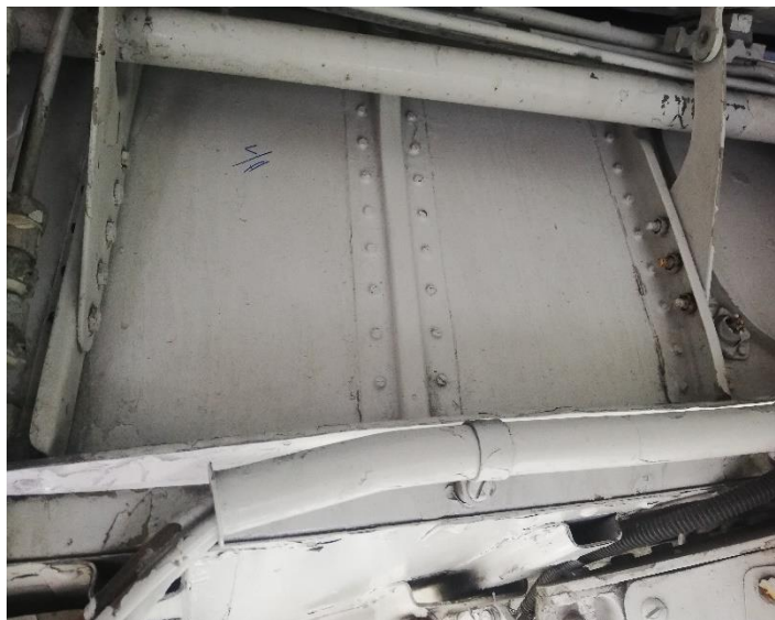
Figura 83 Inspección de la condición de la estructura
