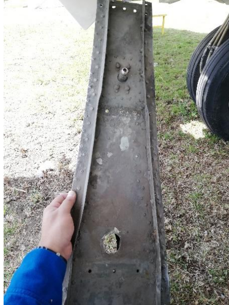
Figura 41 Condiciones del panel IN de las antenas de comunicación HF y VHF
