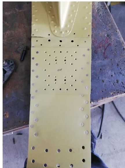
Figura 68 Remachado de lámina de refuerzo en la estructura
