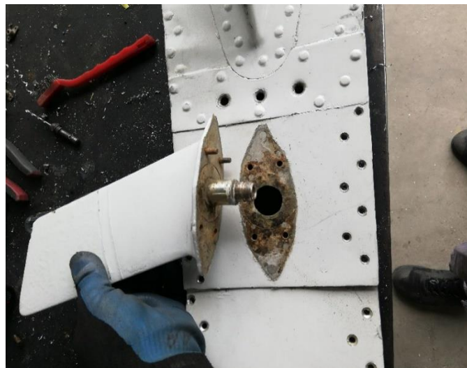
Figura 45 Extracción de tornillos de la antena HF
