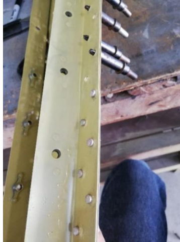
Figura 67 Remachado de láminas en la estructura
