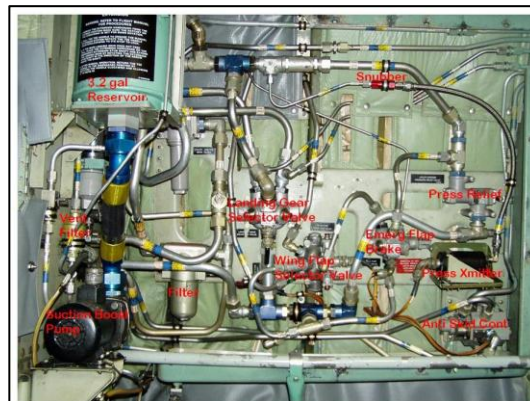
Figura 14. Cañerías rígidas Fuente: (PEÑALOZA, 2009)
