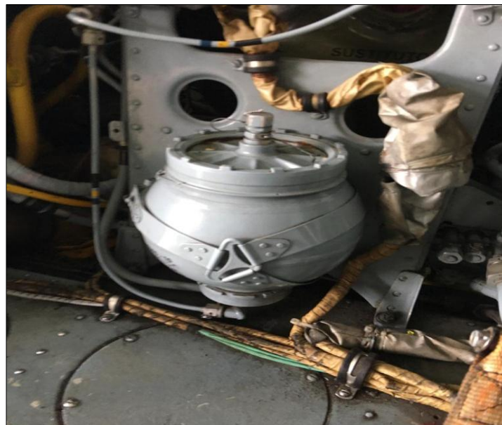
Figura 23. Acceso al reservorio hidráulico
