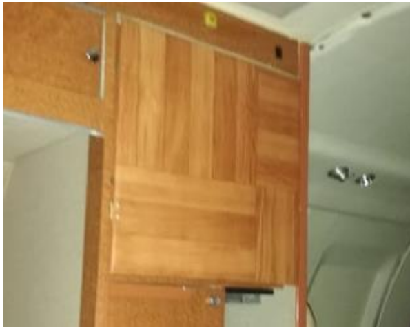
Figura 28. Colocación de la puerta.
