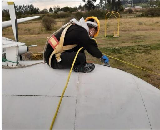
*Nota* : Se puede apreciar la remoción de la pintura para realizar el tratamiento anticorrosivo.
