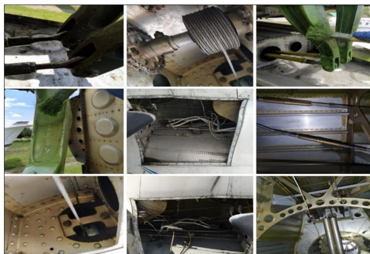
Figura 102. Instalación de los componentes de mando.
