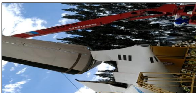
Figura 66. Elevación del estabilizador horizontal.
