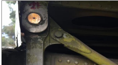
Figura 92. Colocación del perno.
