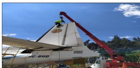
Figura 100. Retiro de la eslinga.
