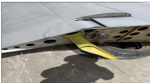
Figura 61. Soporte del estabilizador.
