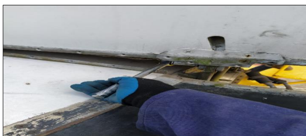
Figura 58. Retiro de pernos del estabilizador.
