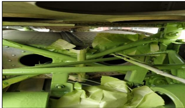
Figura 85. Colocación del anticorrosivo.
