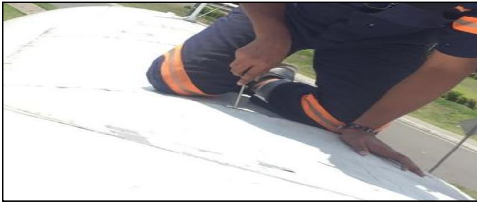
Figura 39. Instalación del carenado superior del motor
