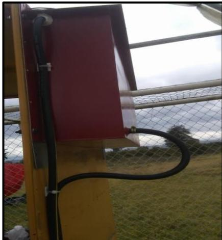
Conexión de retorno de combustible y de salida de combustible
