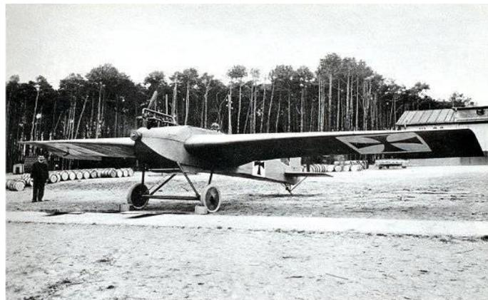
**Figura 8** El Junker J-1 construido todo en metal en 1910
