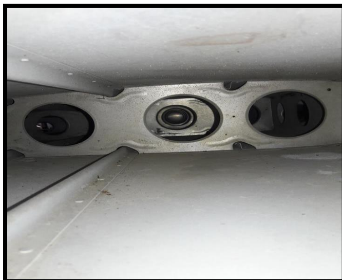
Figura 37 Parte interna limpia.
