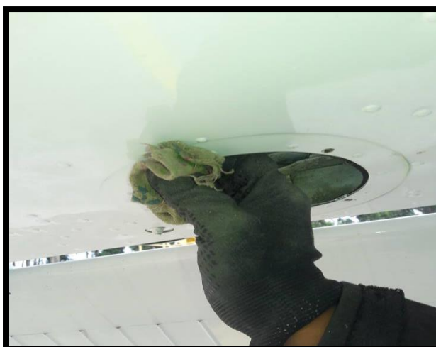
Figura 42 Limpieza de bordes de tapas de inspección
