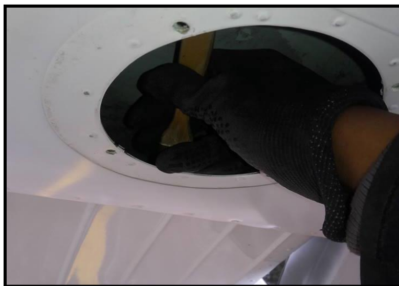
Figura 33 Limpieza con brocha
