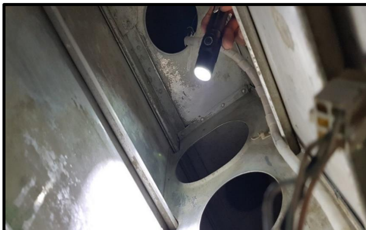
Figura 45 Inspección con linterna
