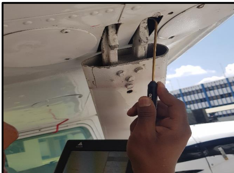
Figura 64 Inspección NDI en el strut
