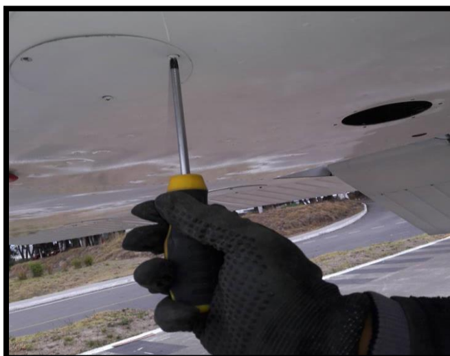
Figura 38 Removiendo tapas de inspección
