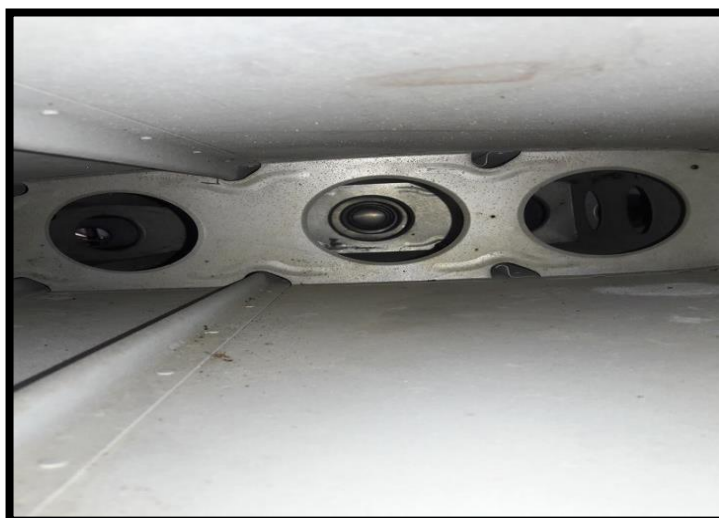
Figura 46 Miembro estructural principal
