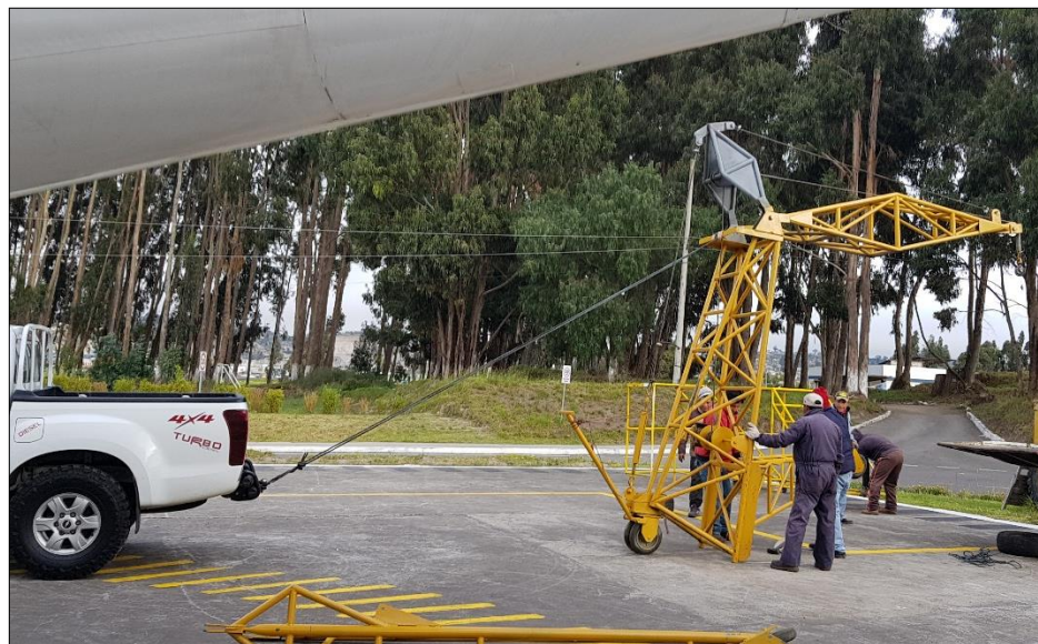
Figura 28 Montaje del tecle
