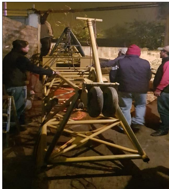
Figura 25 Movilidad del tecele a la grúa
