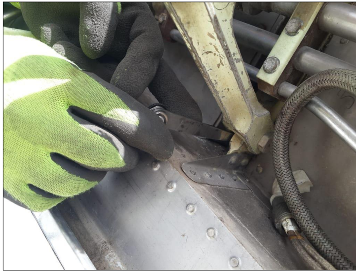
Figura 39 Inspección enlace inferior
