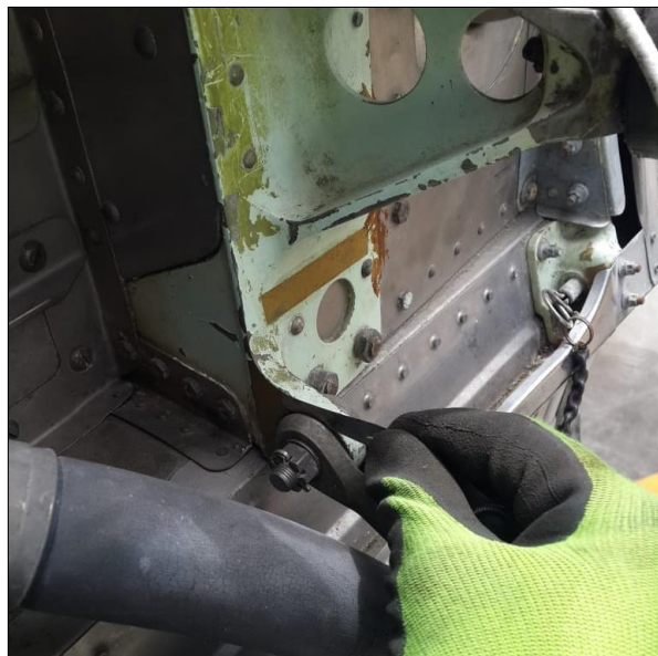
Figura 41 Inspección enlace posterior
