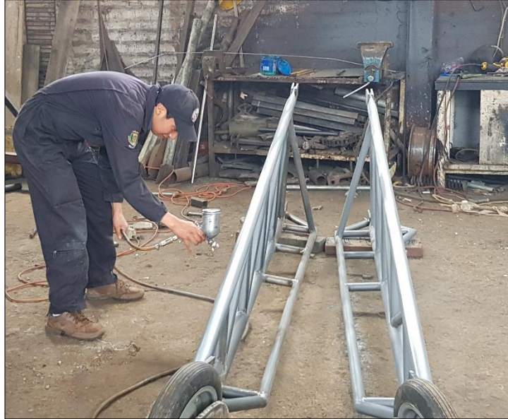
Figura 23 Aplicación del fondo de pintura
