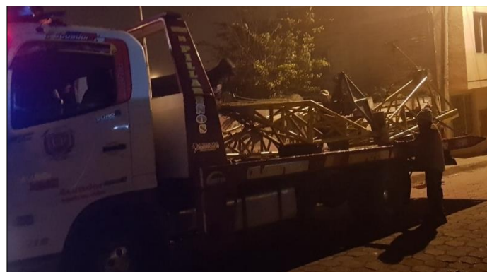
Figura 26 Montaje del tecele en la grúa
