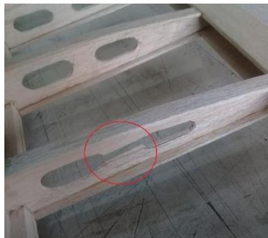
Nota. En la imagen se puede observar como evidencia, la rotura en la zona media de las costillas, la cual fue reparada para mayor resistencia.
