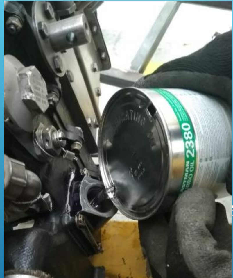
Colocación de aceite nuevo
