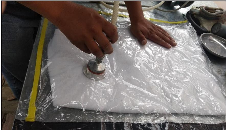
**Figura 31.** Bolsa de vacío en función de la reparación.
