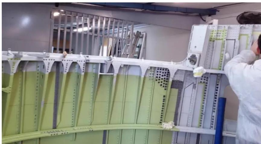
*Nota.* La imagen ilustra el proceso de implementación de sellos en la estructura de la aeronave, tomado de (M&D Aeroespacial s.l, s.f.)
