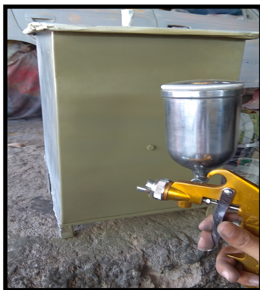
Figura 36 Aplicación de fondo adherente / anticorrosivo
