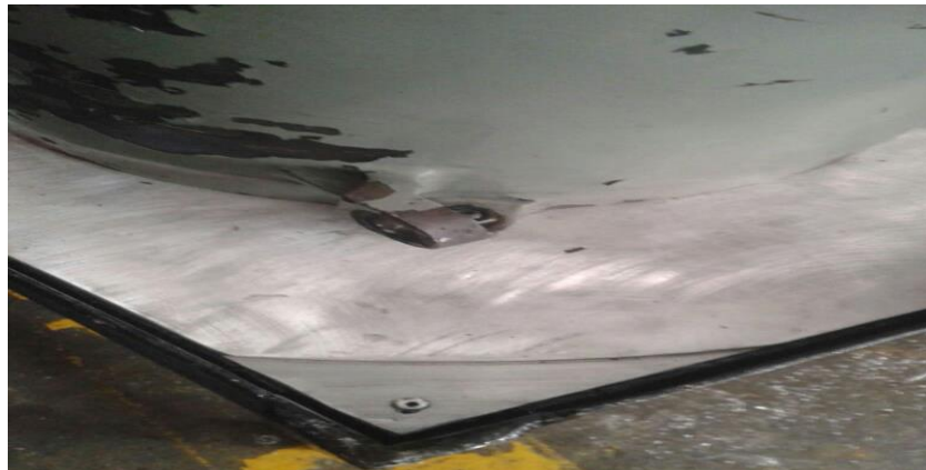
Figura 27 Remachado de la plancha de aluminio.
