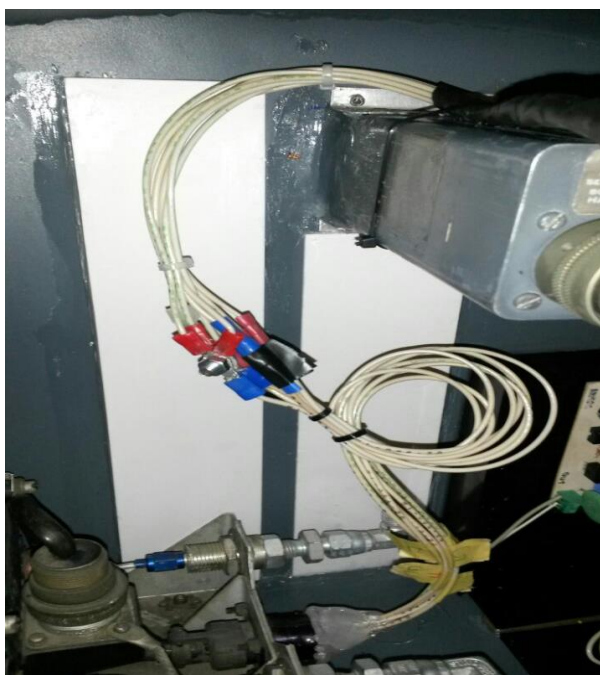
Figura 70 Ruteado de wiring
