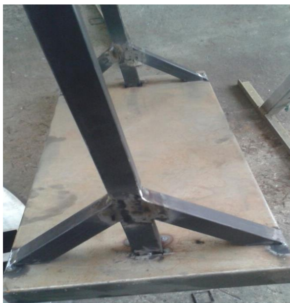
Figura 50 Base y soporte terminado
