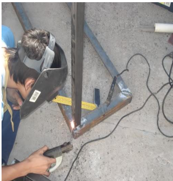
Figura 46 Soldadura de material
