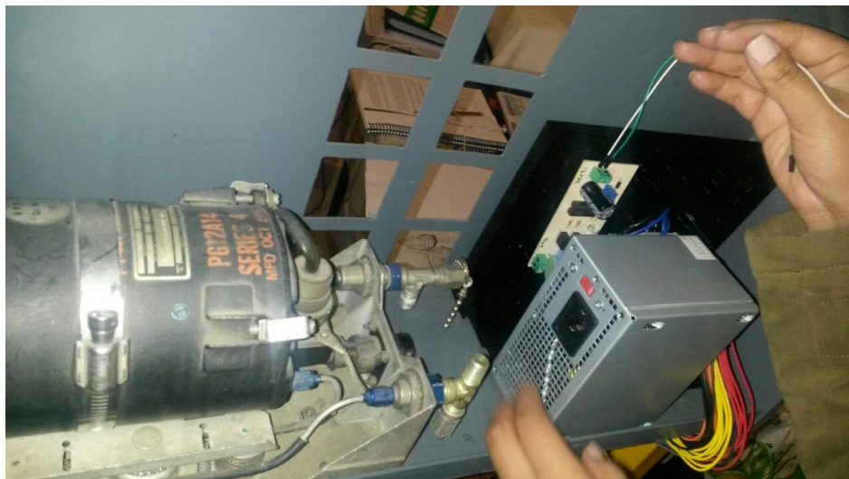
Figura 69 Instalación del sistema EPR
