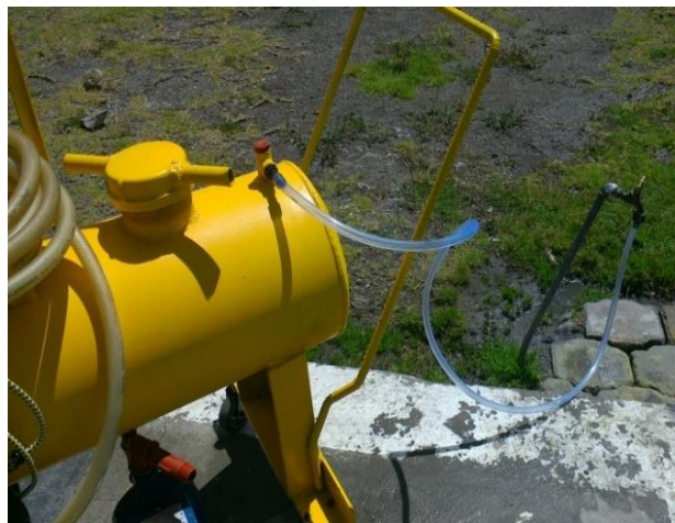
Figura 60 Llenado del tanque
