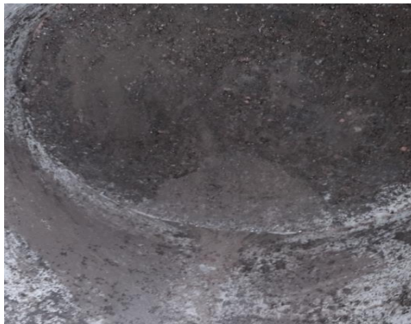
Figura 37 Interior del tanque decapado
