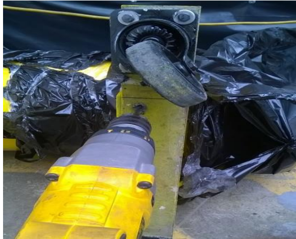
Figura 50 Perforación en la estructura
