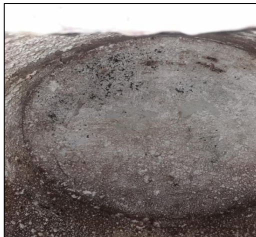
Figura 35 Interior del tanque con removedor
