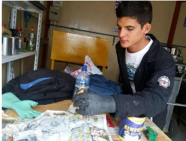
Figura 32 Aplicación del removedor de pintura
