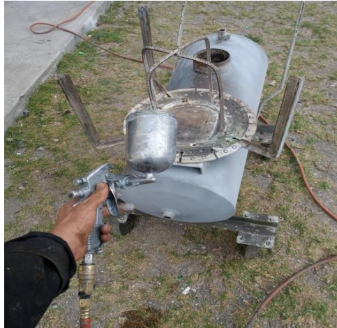
Figura 40 Aplicación de pintura de fondo
