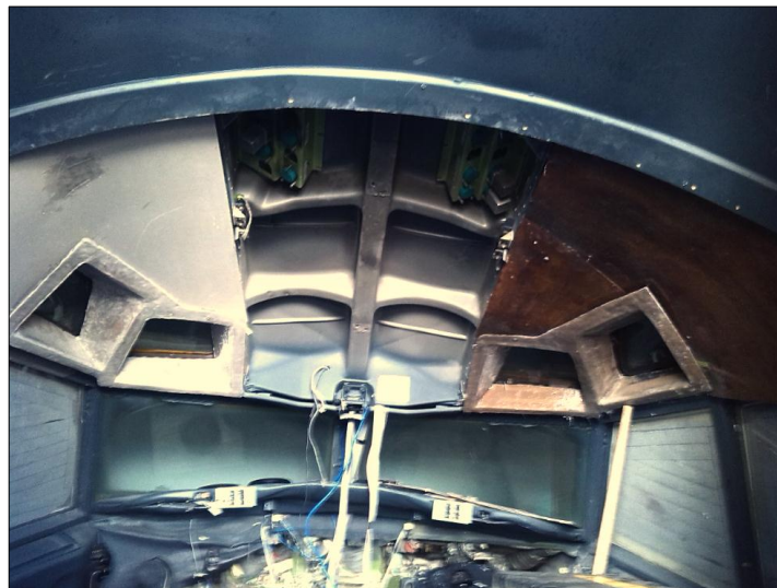
Figura 50 Vista del trabajo casi culminado
