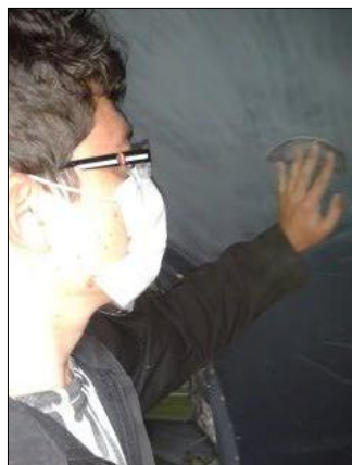
Figura 46 Preparación de la estructura interna
