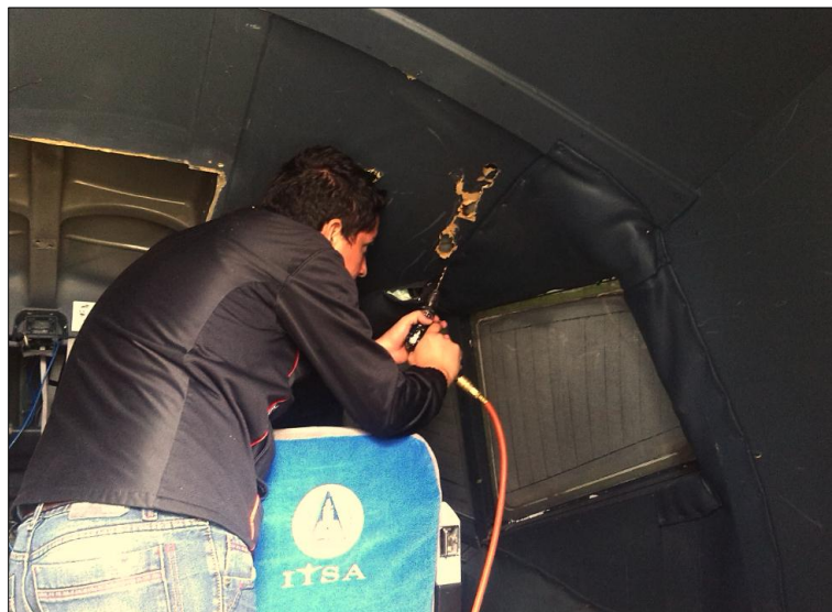
Figura 27 Desmontaje con herramientas neumáticas
