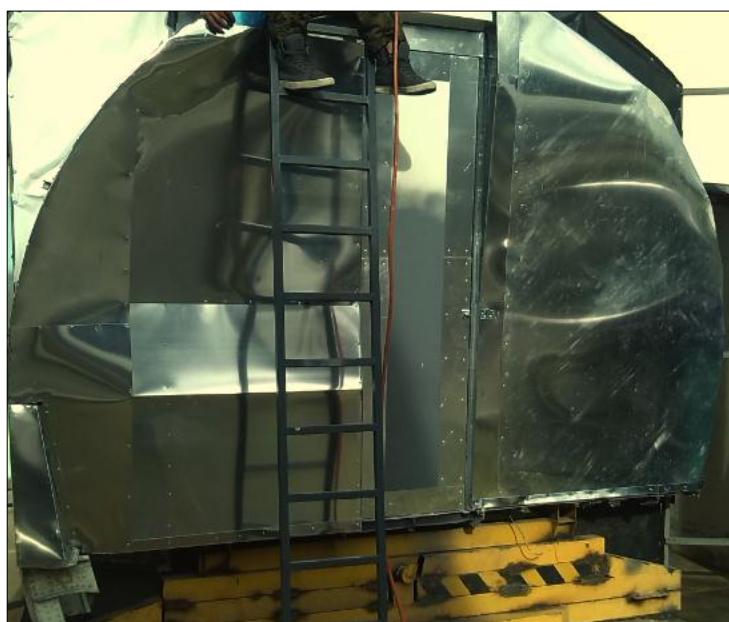
Figura 66 Tarea de aplicación de láminas de aluminio
