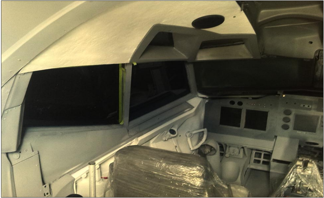
Figura 52 Trabajo de restructuración FRAME y SIDE WALK
