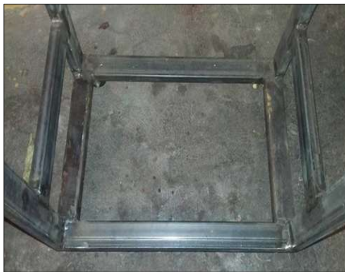
Figura 22 Separadores de la estructura
