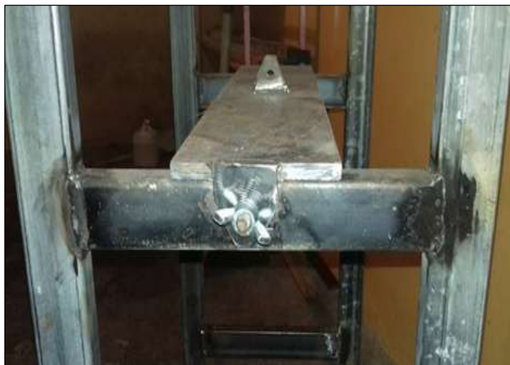
Figura 29 Placa puesta en la estructura metálica
