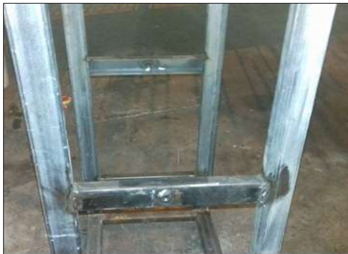
Figura 23 Separadores de la estructura
