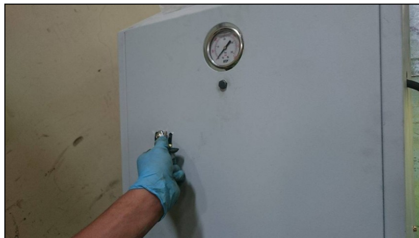
Figura 51: Prueba de manómetro, llave de paso de retorno.
