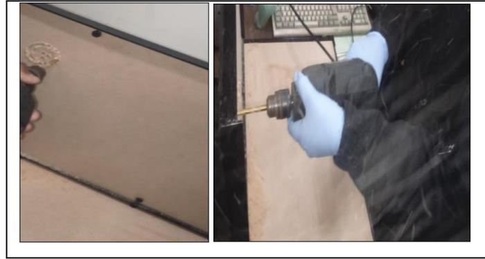
**Figura 36 Perforación de la base del banco**
