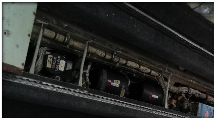
Figura 22. Remoción de los paneles de piso
