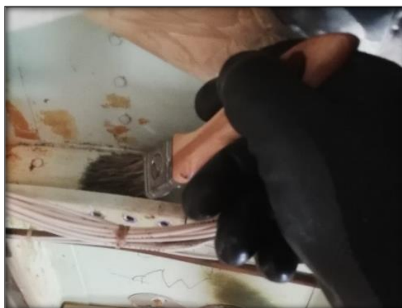
Figura 46. Aplicación de LPS
