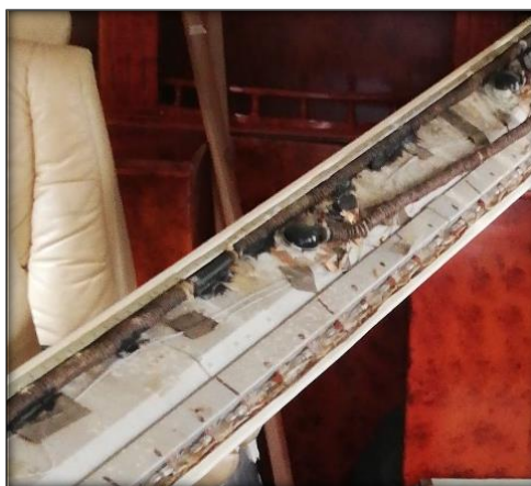
Figura 26. Remoción de paneles.
