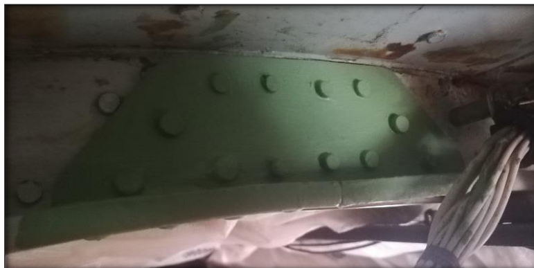
Figura 51. Aplicación de primer
