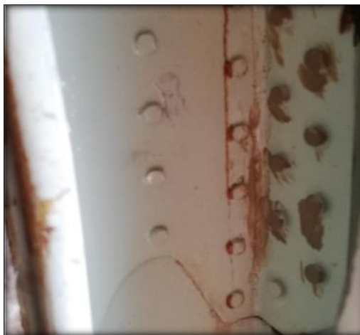
Figura 29. Limpieza de formadores
