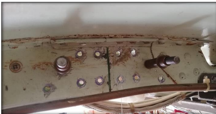
Figura 45. Realización de perforaciones
