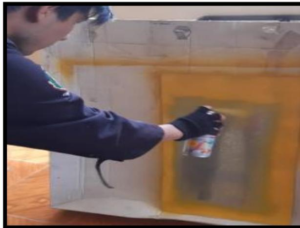
*Nota.* Pintado en aerosol, movimiento de abanico uniforme para evitar derrames
