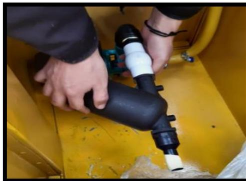
*Nota.* Instalación de accesorios, se ve el filtro y válvula de paso
