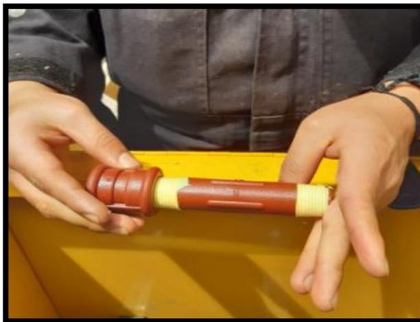
*Nota.* Se ajusta las conexiones con cinta teflón en capas para asegurar mínimas fugas
