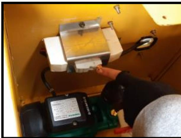
*Nota.* El disyuntor además de servir como interruptor de encendido/apagado previene de descargas que malogren la bomba
