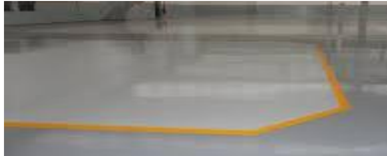
Figura 11 Señalización de áreas
