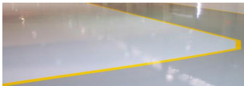
Figura 10 Señalización de áreas
