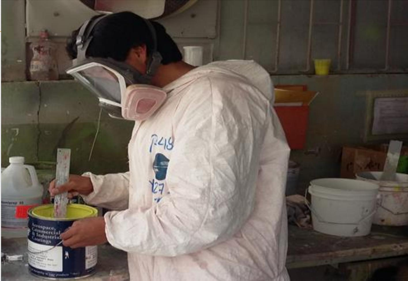
☞ Aplicada la primera mano de imprimante en toda la estructura, se debe esperar de 10 minutos a 2 horas para proceder a aplicar la segunda mano del mismo ya aplicado se debe espera de 4 a 24 horas para su secado
