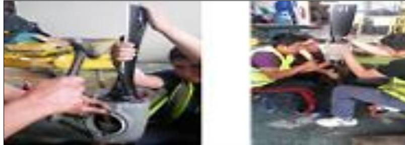
**Figura 63 Ensamblaje de las Palas en el Cubo**
