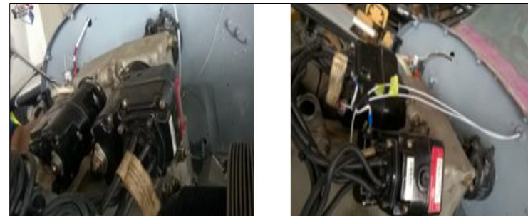
Instalación de los Magnetos
