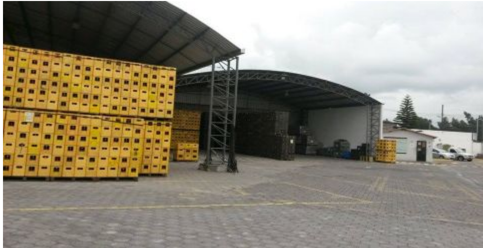
Figura 10 Cubiertas del área de bodegas de la empresa Distriolmedo Cía. Ltda.
