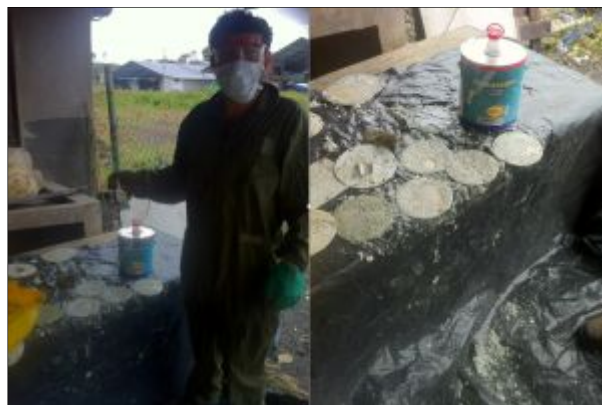
Figura 56 Aplicación de removedor en la tapas de inspección
