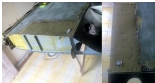
Figura 68 Colocación de parche rectangular
