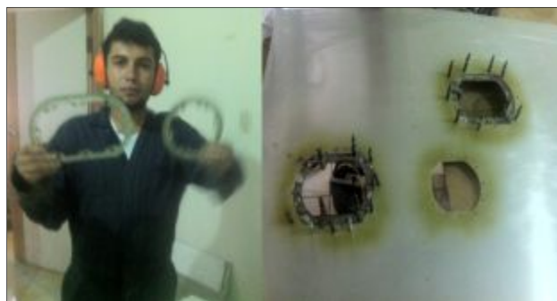
Figura 75 Fijación de los marcos de las tapas de inspección
