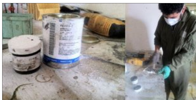
Figura 74 Preparación de sellante de combustible P/S 870 B-2 (PRC)
