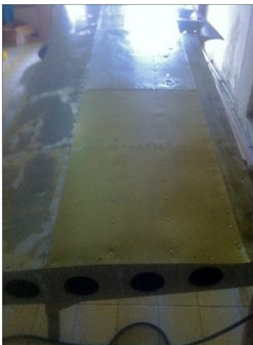
Figura 69 Reemplazo de lámina en mal estado. (WS 172.00 hasta la WS 208.00)
