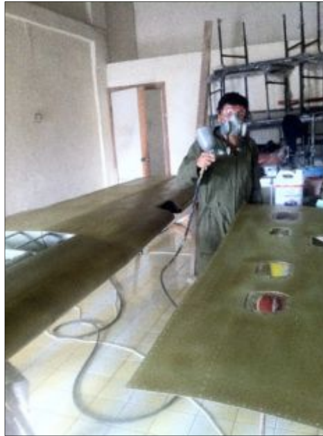
Figura 81 Aplicación de Primer al ala
