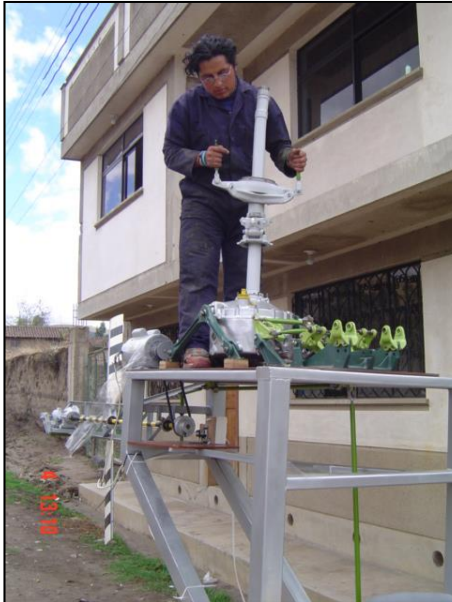
Fig 3.34. Montaje de las piezas sobre la estructura.
