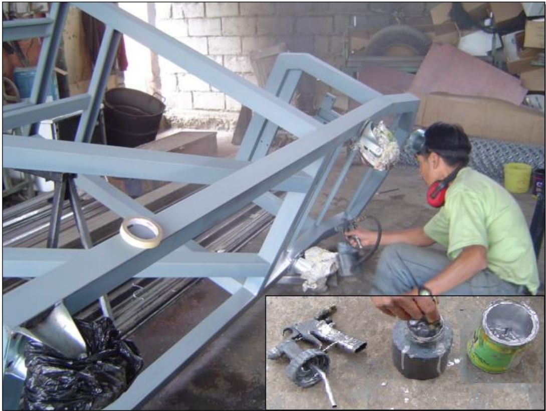
Fig. 3.21. Preparación de la pintura y aplicación.
