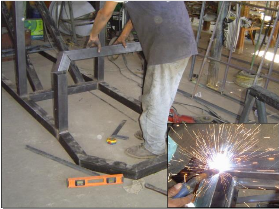
Fig. 3.18. Soldado del soporte de los mecanismos de control de vuelo.
