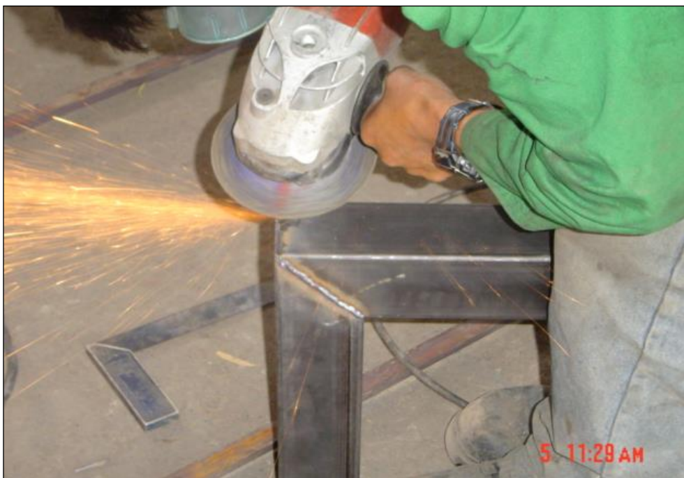
Fig.3.19. Amolado de la estructura.
