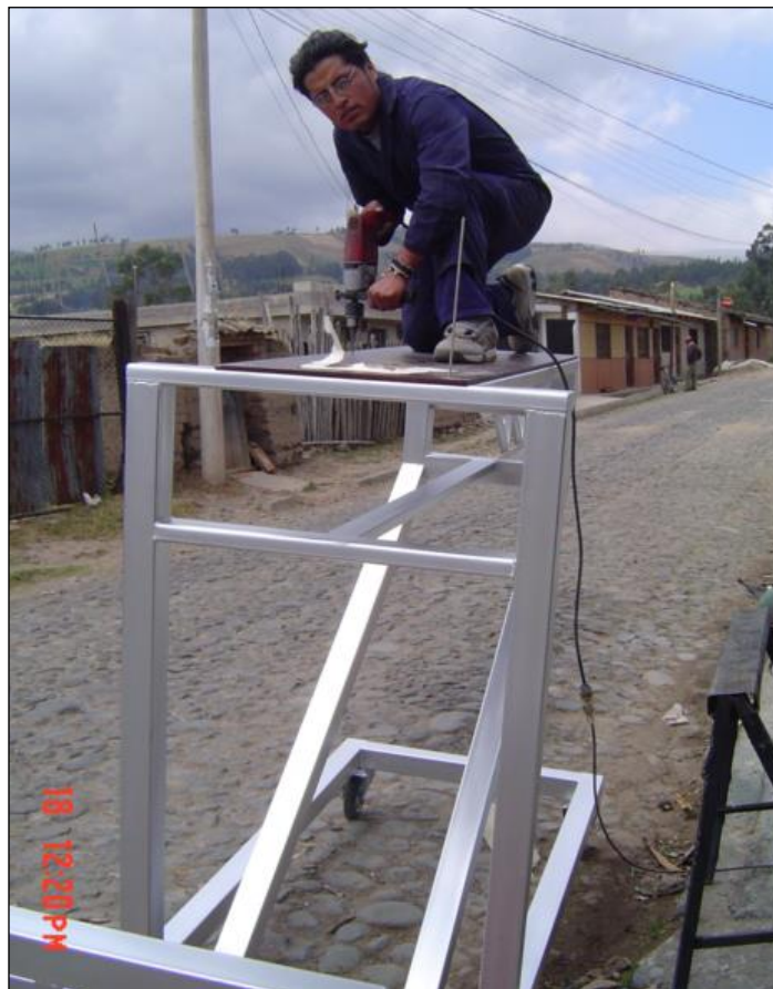
Fig. 3.23. Colocación de las triplex con remaches 3/16 x 1"
