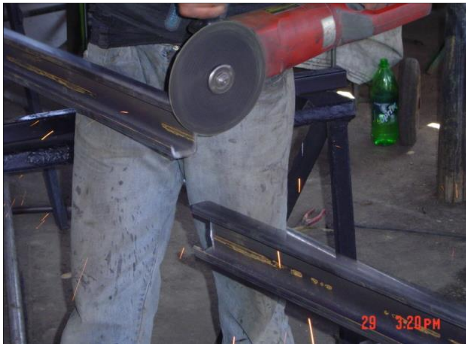
Fig. 3.11. Corte del perfil "G"
