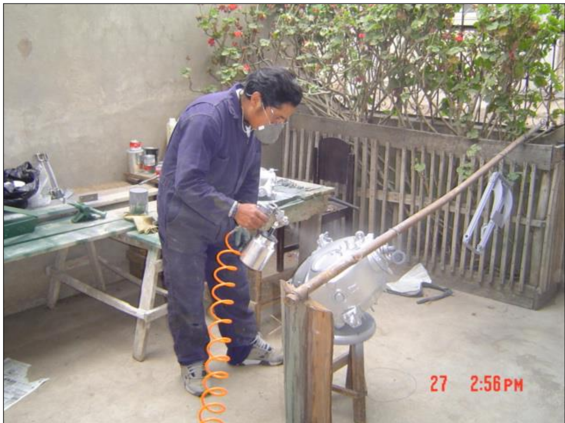
Fig.3.28. Aplicación de la segunda capa de pintura.
