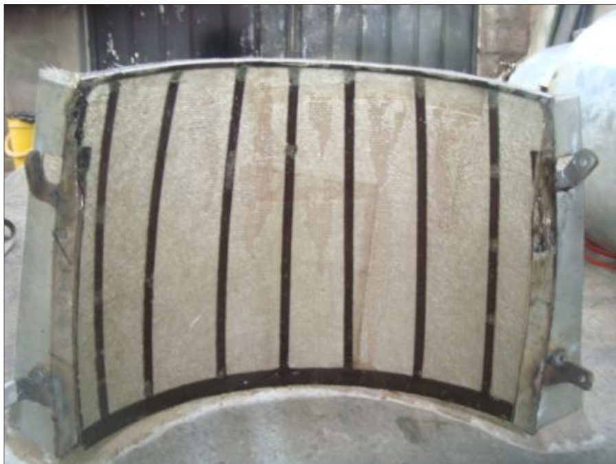
Figura 3. 12: Cubriendo la estructura con fibra de vidrio
