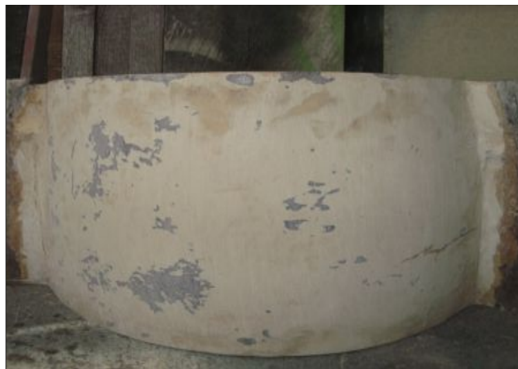
Figura 3. 14: Lijado del masillado de compuertas
