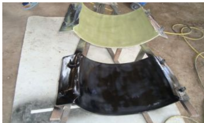
Figura 3. 16: Fondeado y pintado de las compuertas
