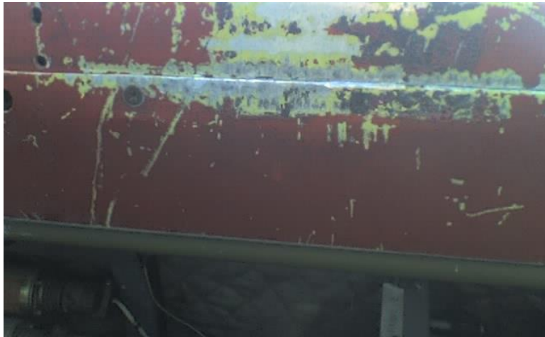
Figura2.1 Parte lateral de la cabina en mal estado
